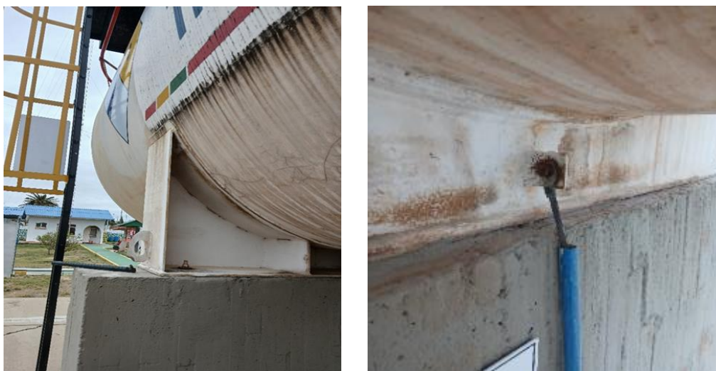
Figura 5. Estado actual de las orejas de izaje, puesta a tierra, cunas y patas de soporte del Tanque V-09
